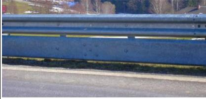
1. Einer **Blechschrürze** aus verzinktem Stahlblech mit einer glatten elastischen Oberfläche und einer Höhe von 37cm. Bei einem Aufprall absorbiert sie dank ihrer Oberflächeneigenschaft und dem Nachgeben bis zum hinten befindlichen Leitschienensteher einen Teil die freigewordenen Energie.
