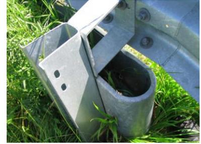
3. **End- und Anfangmodule** schließen das System längsseitig ab und geben der Blechschrürze stabilen Halt. Sie werden entweder an einem Leitschienensteher angeschraubt oder mit einem im Boden verankertem Montagepflock fixiert.
