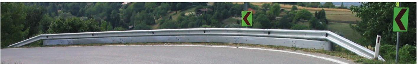
Der Unterfahrschutz aus einem speziellen Blechprofil ist eine sehr gute Lösung
