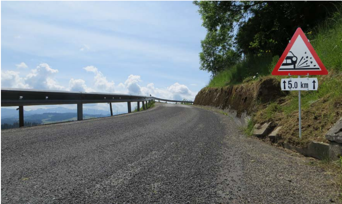
Abb. 73: Aufbringen von Rollsplitt zur Erhöhung der Griffigkeit
