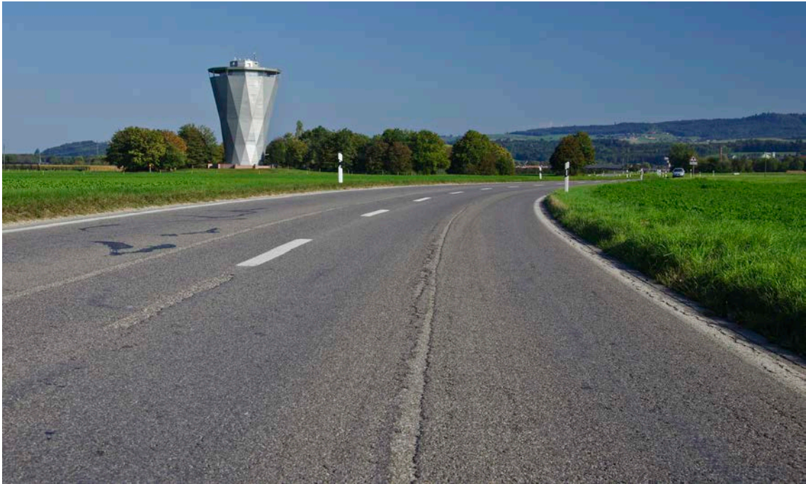
Abb. 63: Spurrille fahrstreifenmittig (aufgrund unsachgemäsem Deckbelagseinbau)
