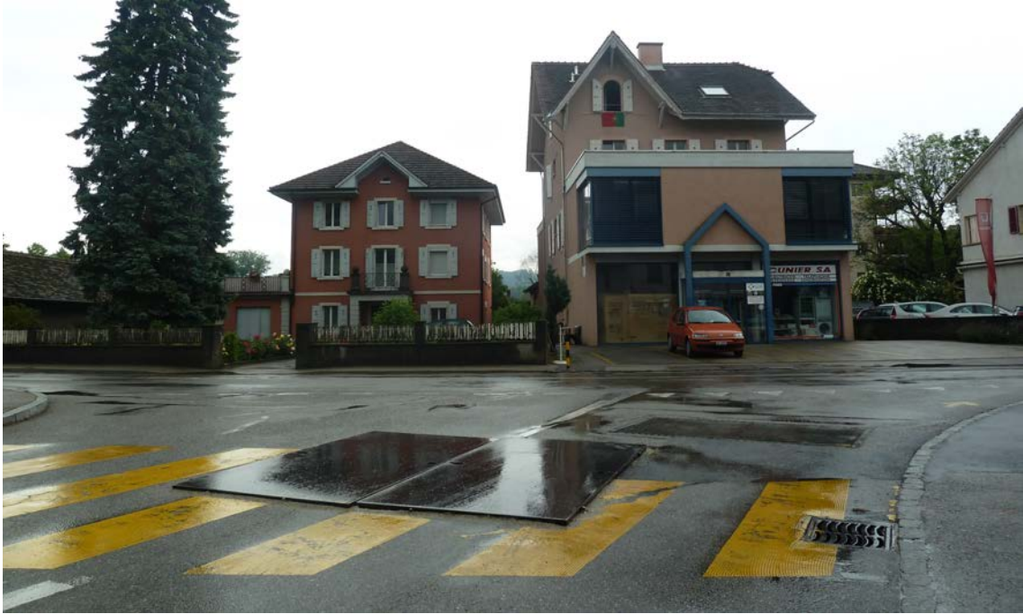
Abb. 36: Schlechtes Beispiel einer Grabenabdeckung
