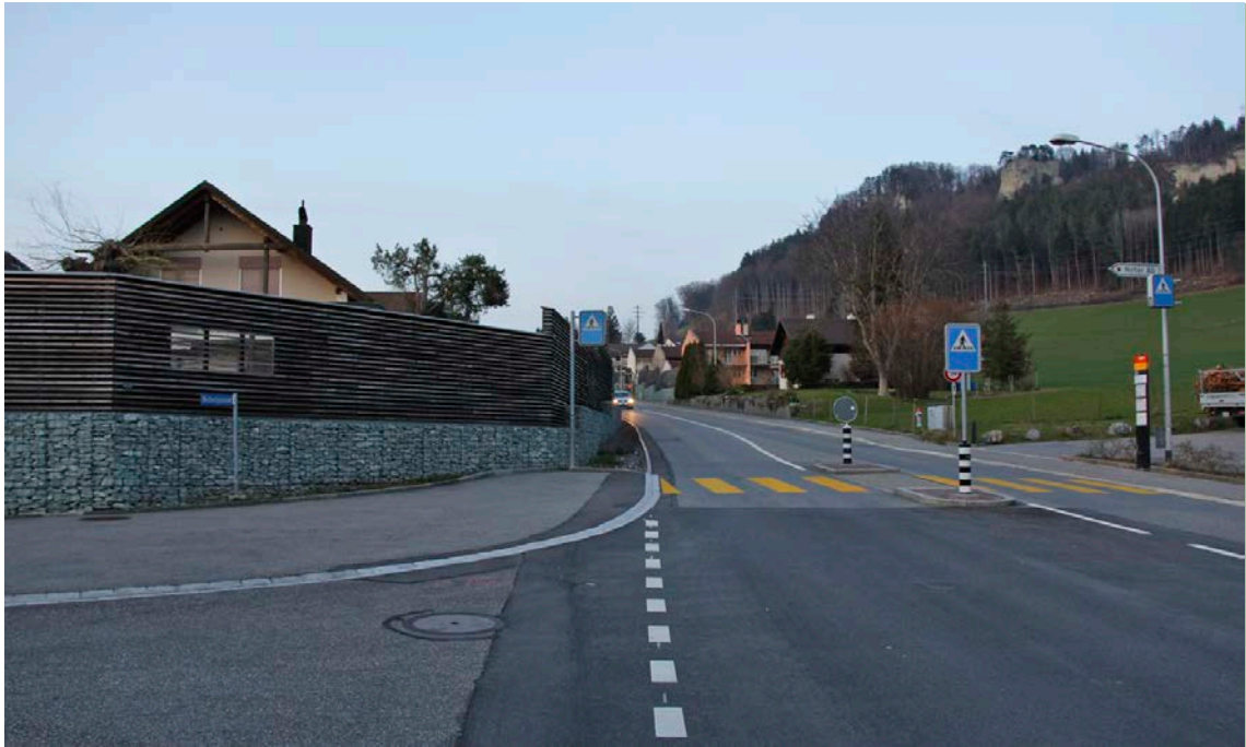
Abb. 32: Sichtbeeinträchtigung durch Lärmschutzwand
