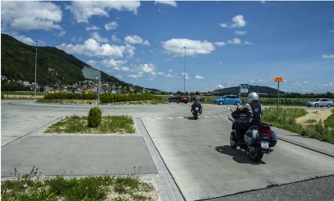
Abb. 75: Kreisel mit Kreiselfahrbahn sowie Ein- und Ausfahrten mit Betonbelag realisiert
