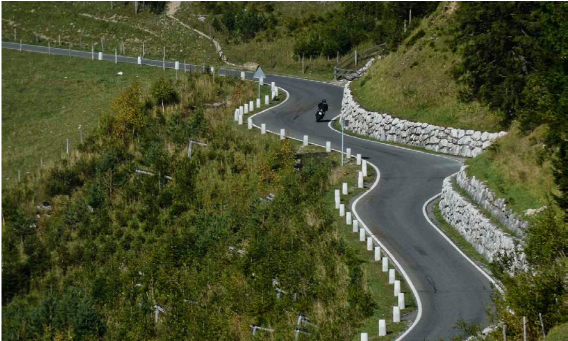
Abb. 83: Wehrsteine zur talseitigen Absturzsicherung
