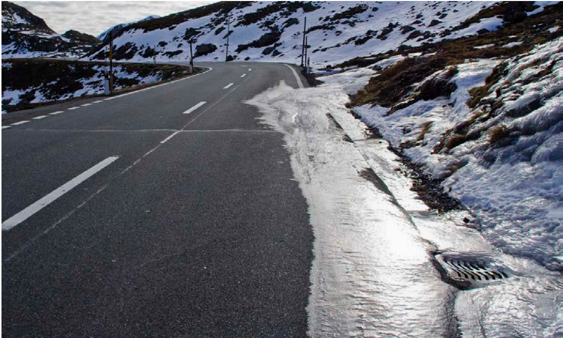
Abb. 71: Vereiste Fahrbahn aufgrund ungenügendem Schmelzwasserabfluss
