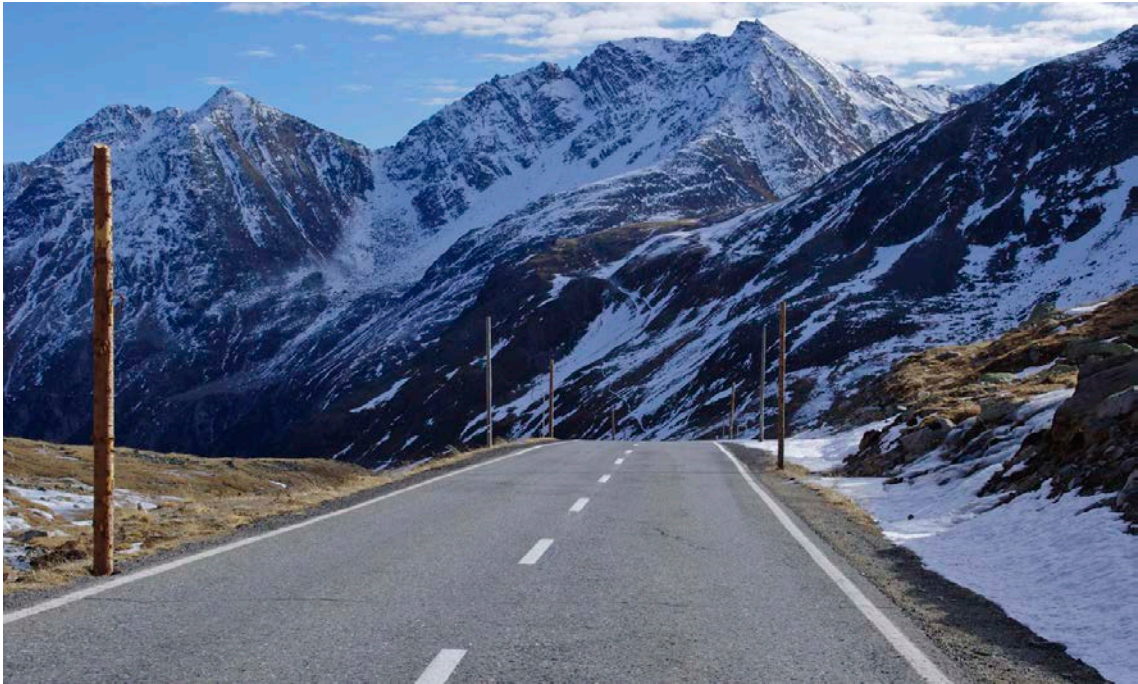
Abb. 50: Schlecht erkennbarer Strassenverlauf hinter der Kuppe.
