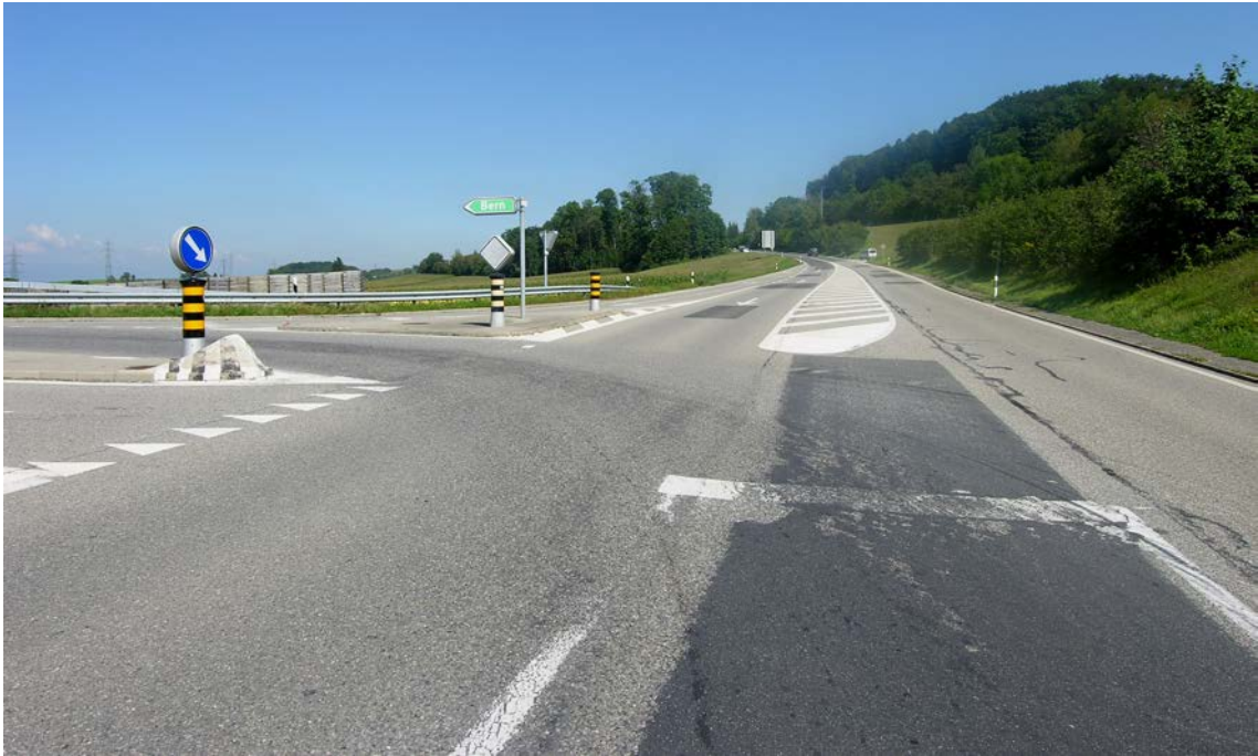
Abb. 67: Abgenutzte Markierung ausserorts
