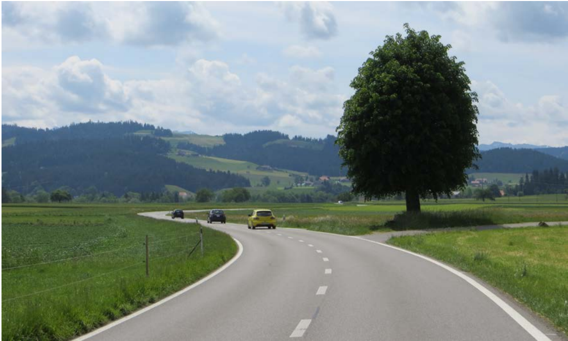
Abb. 79: Einzelbaum in potentiellem Sturzraum (Kurvenaussenseite) eines Motorrades
