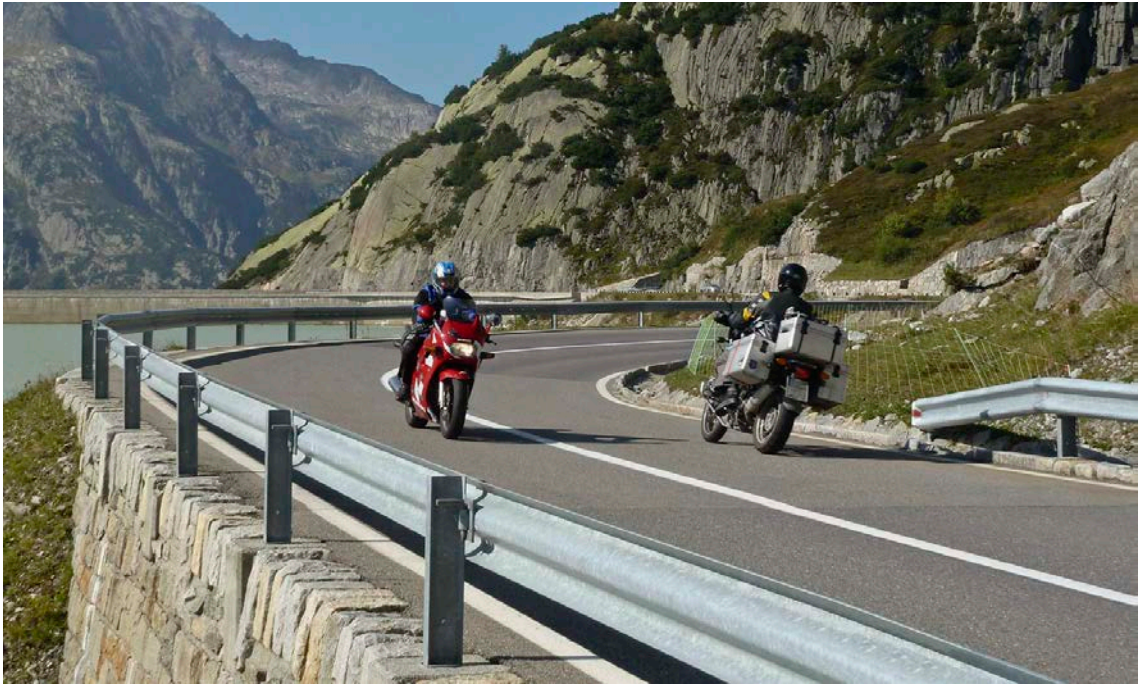
Abb. 85: Fahrzeugrückhaltesystem mit Pfosten (IPE) und Leitprofil
