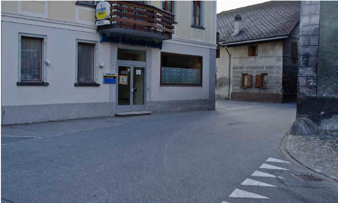
Abb. 22: Beispiel einer Einmündung mit deutlich unterschrittenen Mindestsichtweiten
