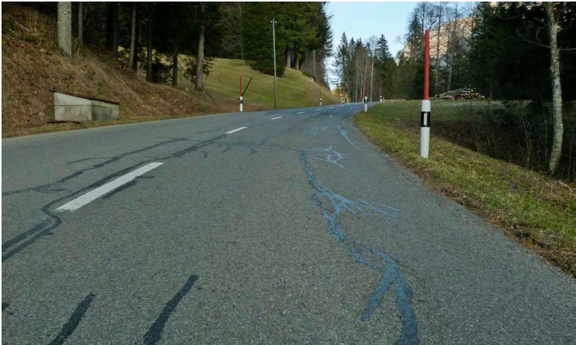
Abb. 60: Bitumenreparaturen von Fahrbahnrisse
