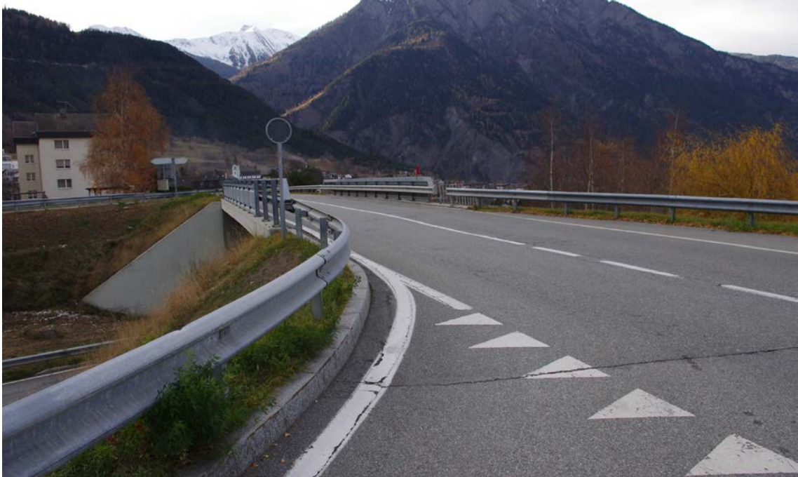
Abb. 34: Sichtbeeinträchtigung durch Fahrzeugrückhaltesystem
