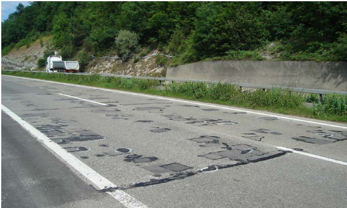
Abb. 57: Flickenteppich nach mehrmaligen Belagsreparaturen
