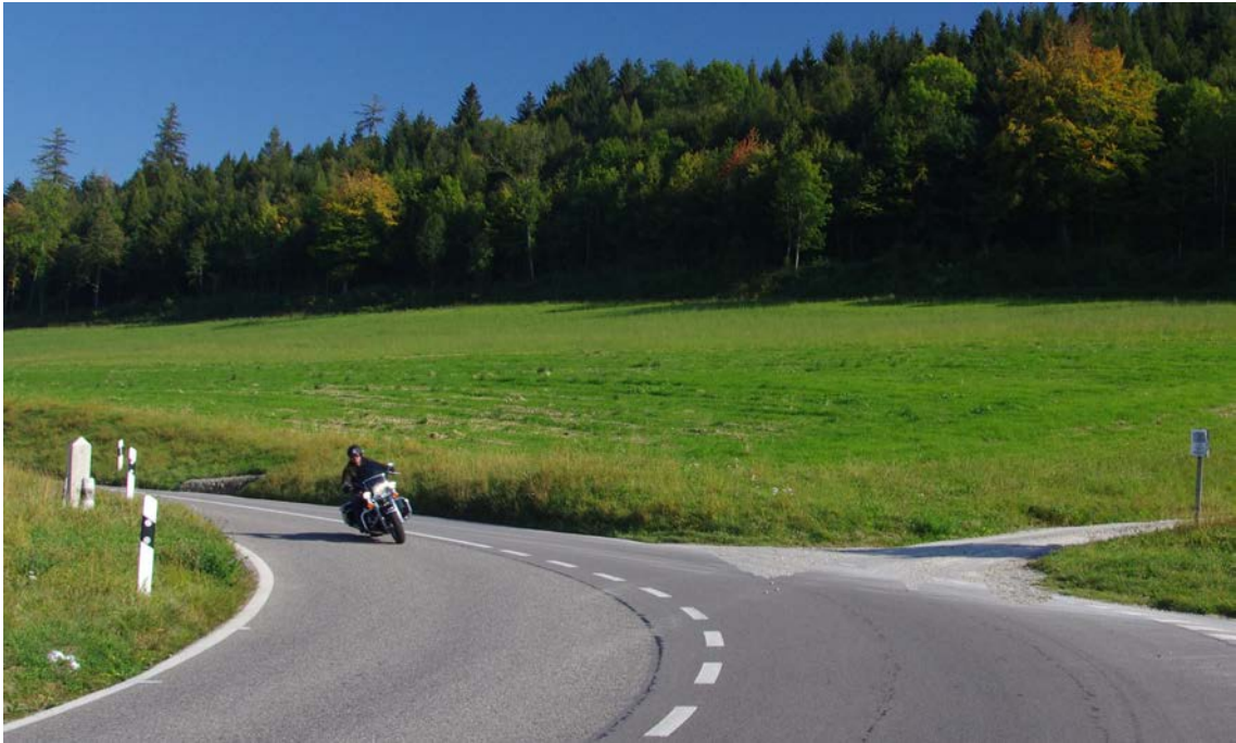
Abb. 69: Verschmutzung der Fahrbahn durch Schotter (ungenügend befestigter Feldweg)
