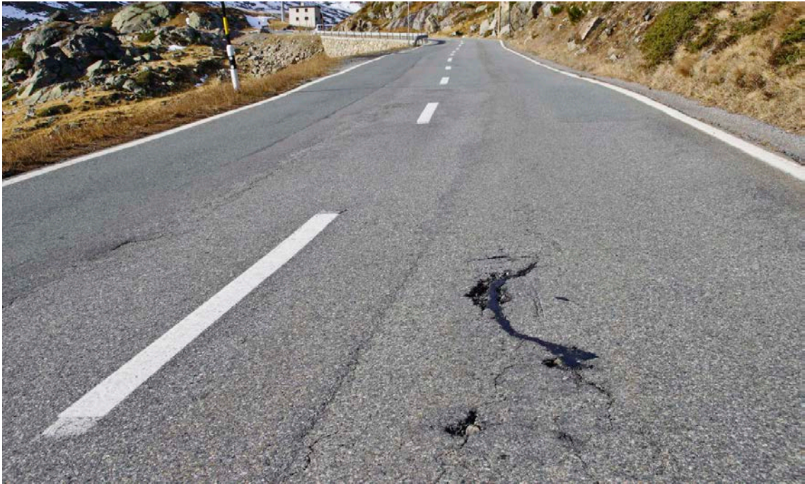
Abb. 54: Schlagloch mit partieller Bitumenreparatur
