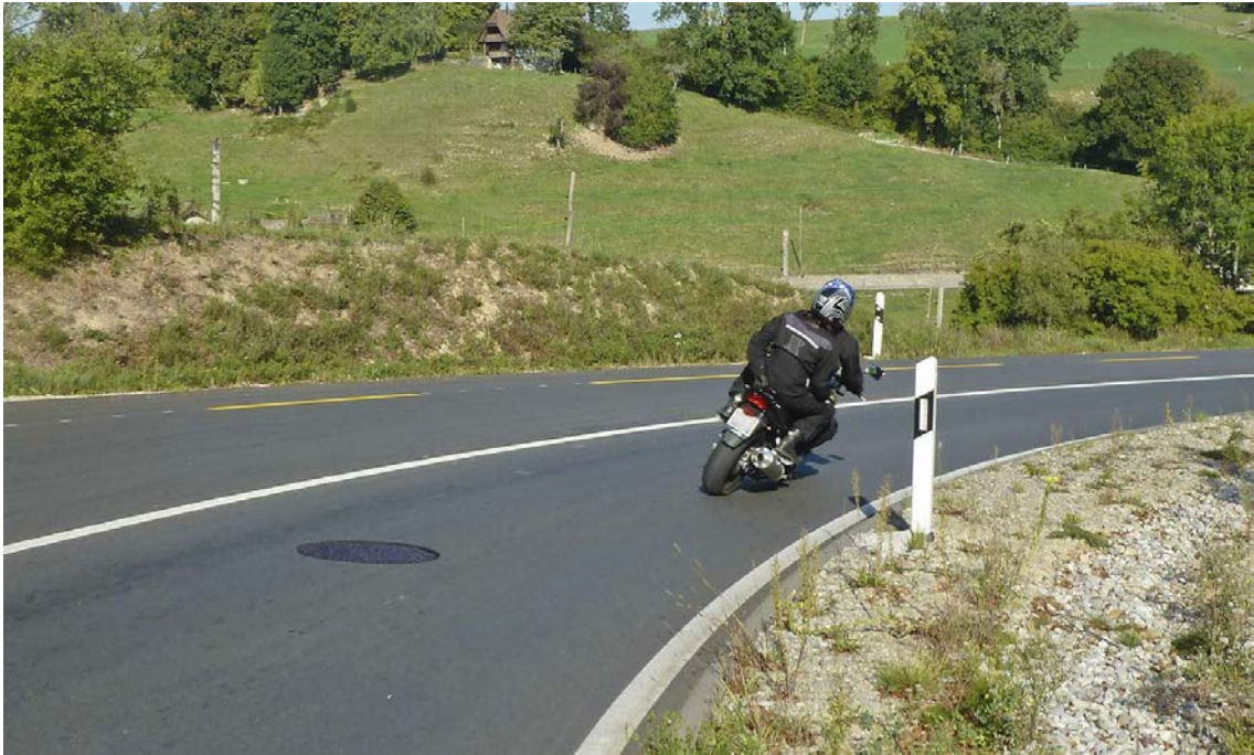
Abb. 77: Schachtdeckel auf Fahrlinie Motorrad
